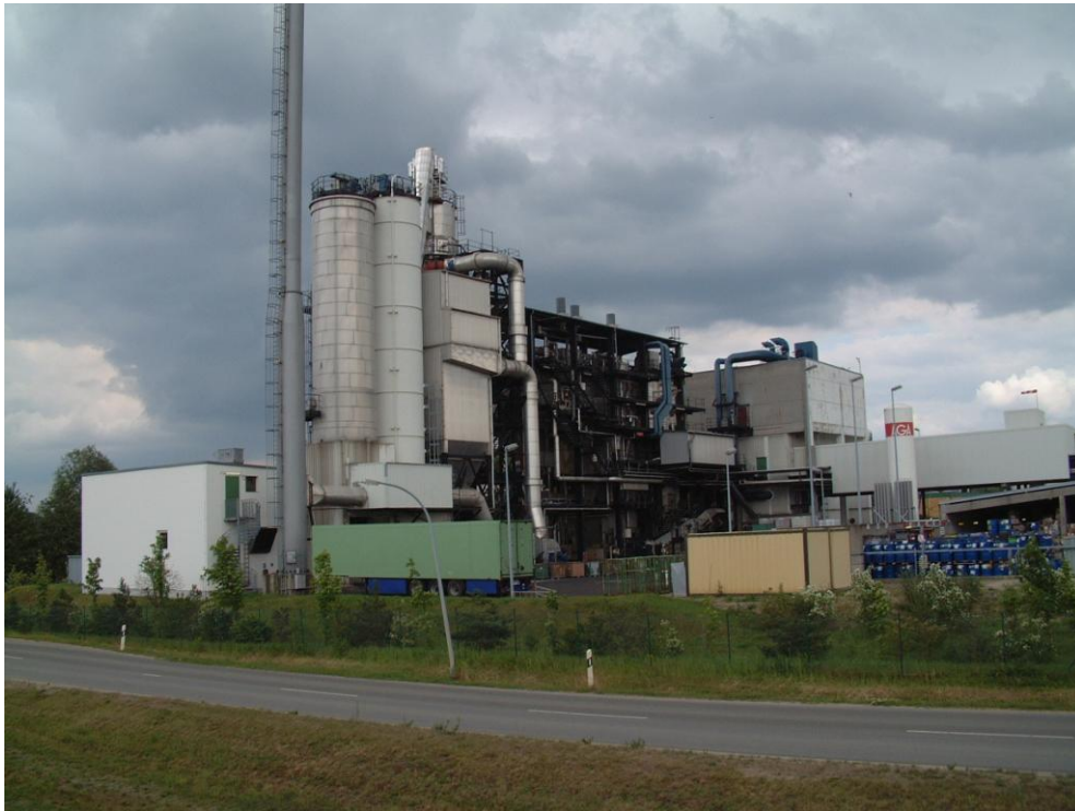
Sonderabfallverbrennungsanlage der MEAB
