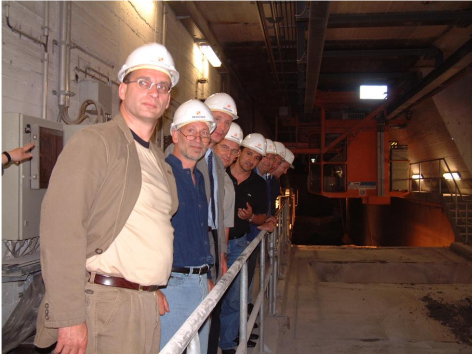
Die Verbrennungsrückstände werden im Schlackebunker gesammelt. Dem Überwachungsausschuss werden hier die Lagerung und die Metallabtrennung der Verbrennungsrückstände erläutert
